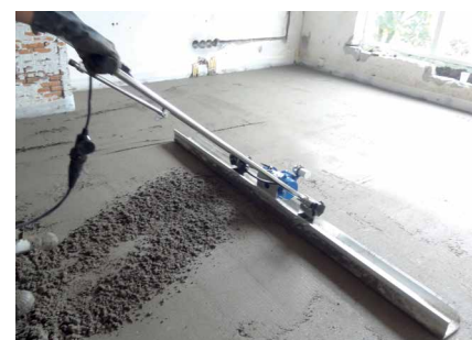
De BreMAT FloorBlaster wordt aangedreven door een elektro- of een 4-tact benzinemotor.
