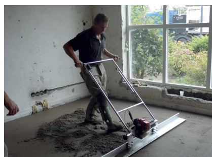
Alleen de zijdelingse banen dienen traditioneel aangebracht te worden. Tusseliggende vlakken kunnen vanuit een staande houding machinaal worden geëgaliseerd en verdicht.
